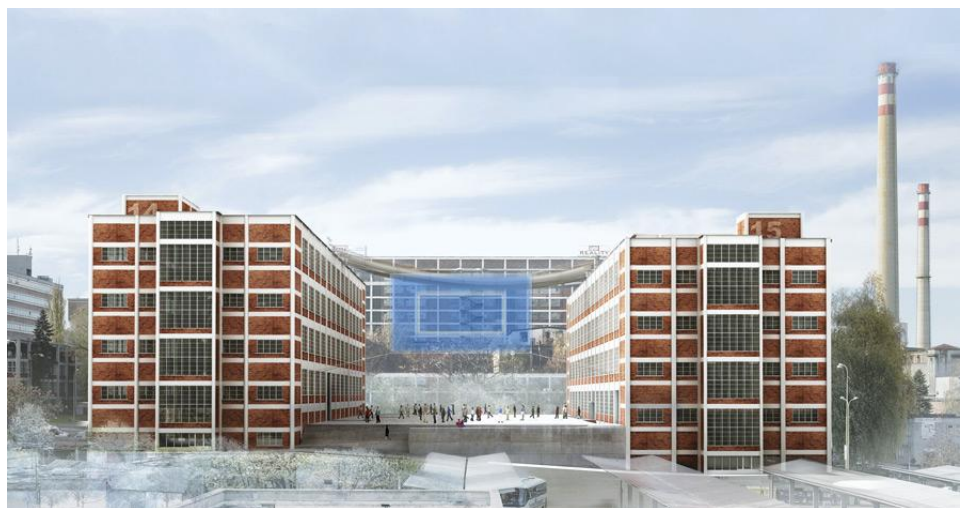
Revitalizace 14. a 15. budovy bývalého areálu firmy Baťa
